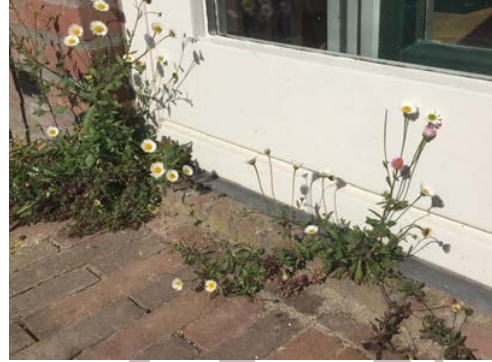
Figuur 2. Op dit deel van de verharding wordt niet gelopen en zijn planten gaan groeien.
